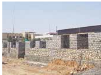
Construction de l'école municipale à Qaraqosh, en Irak.
